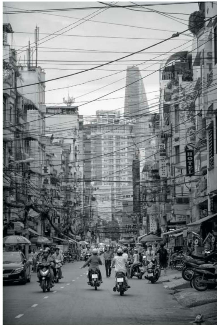
Ici, les lignes constituent le sujet de l'image. Dans cette grande ville d'Asie du Sud-Est, les réseaux électriques et téléphoniques s'ajoutent les uns aux autres sans que l'on essaie de les camoufler. L'ensemble donne un réseau d'innombrables fils tendus comme une toile au-dessus de la rue. 50 mm, 400 ISO, 1/200 s, f/8
